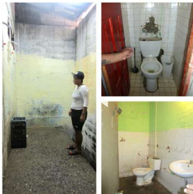
Foto 12. Duchas en Colón (izquierda), inodoro en el Hogar 10 (arriba derecha) y baño en Colón (abajo derecha)
